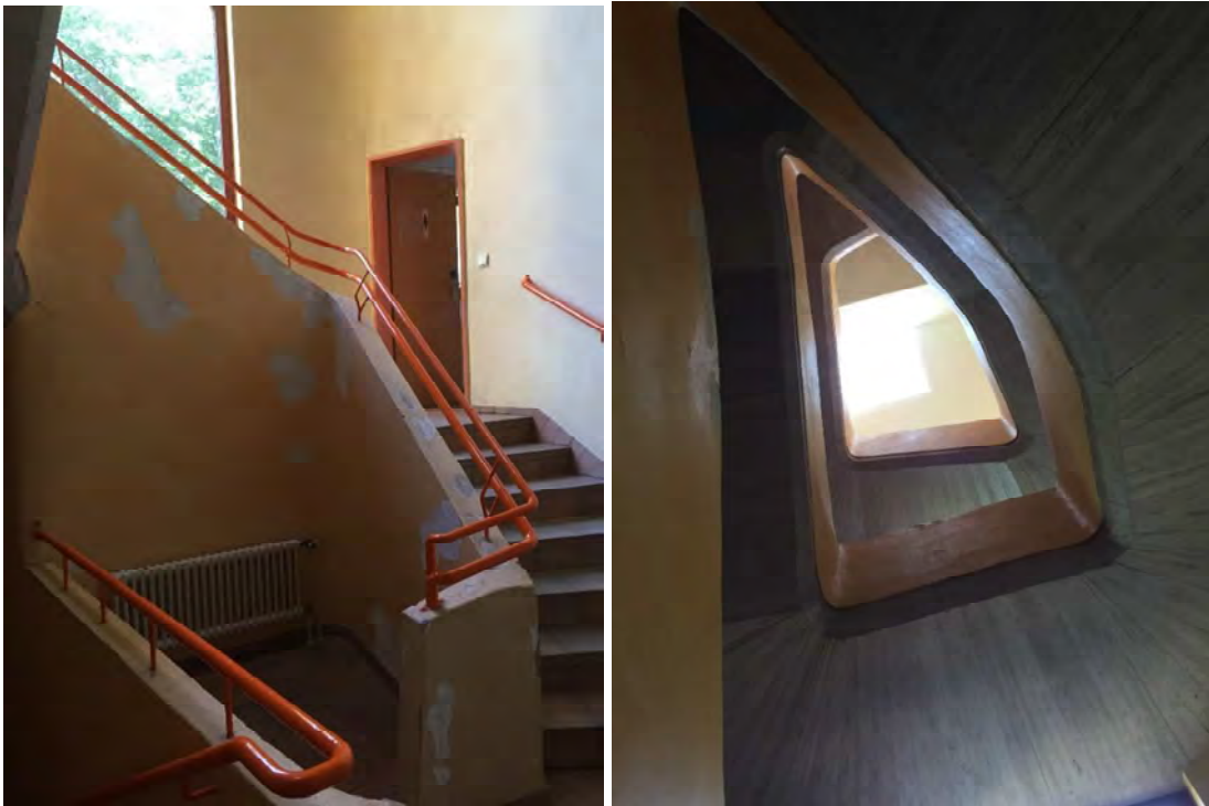
Das hintere Treppenhaus, 4 ½ Etagen
